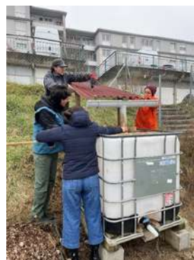
Étape 3 : Mise en place et fixation du collecteur
